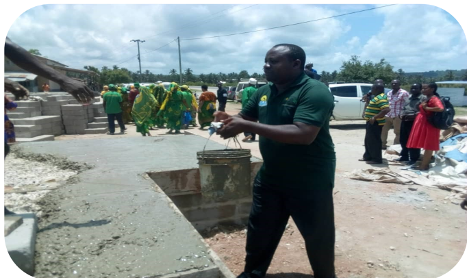
Mstahiki Meya wa Manispaa Geoffrey Mwanichisye akishiriki katika ujenzi wa Choo cha Mwalo wa Milumba
