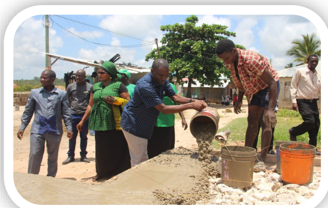
Kaimu Mkurugenzi wa Manispaa Grayson Orcado akishiriki katika ujenzi wa choo katika mwalo wa Milumba
